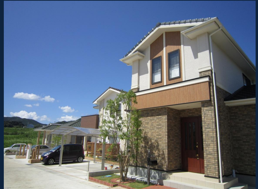
平山建設分譲地施工事例写真
